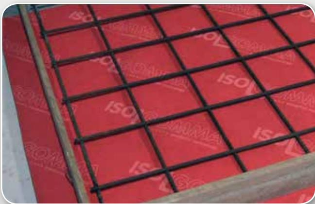
Dimensionare e predisporre adeguatamente l'armatura nel cassero del basamento in relazione allo spessore del massetto
