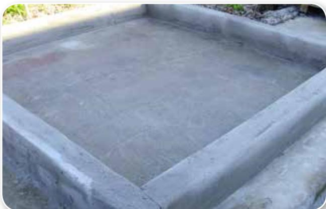
Realizzare il cordolo di contenimento (in cemento oppure mediante profili metallici ad L)
