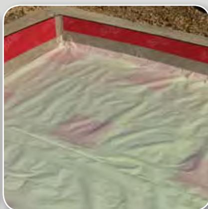
Sigillare le giunzioni verticali con nastro adesivo Stik (ed eventuali fessure tra i componenti orizzontali, se superiori ai 2 mm) e applicare un telo protettivo prima della realizzazione del basamento flottante
