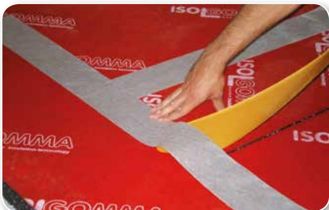
Sigillare le giunzioni orizzontali accuratamente con nastro adesivo Stik
