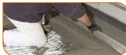
Gettare il massetto in sabbia e cemento o autolivellante Build the screed (sand and cement or self-levelling)
