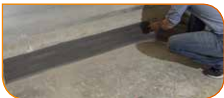
Incollare la striscia perimetrale Profyle Flat alla parete senza ripiegarla alla base del solaio Apply the edging strip Profyle Flat vertically along the perimeter
